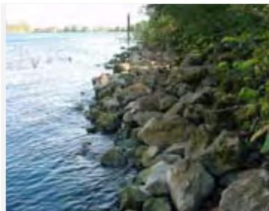
Uferverbau durch Blockwurf unterhalb der Untersuchungsstelle (Zusatzprobe)
